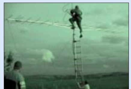
Jussi, OH6ZZ, bei Arbeiten am Powersplitter.
